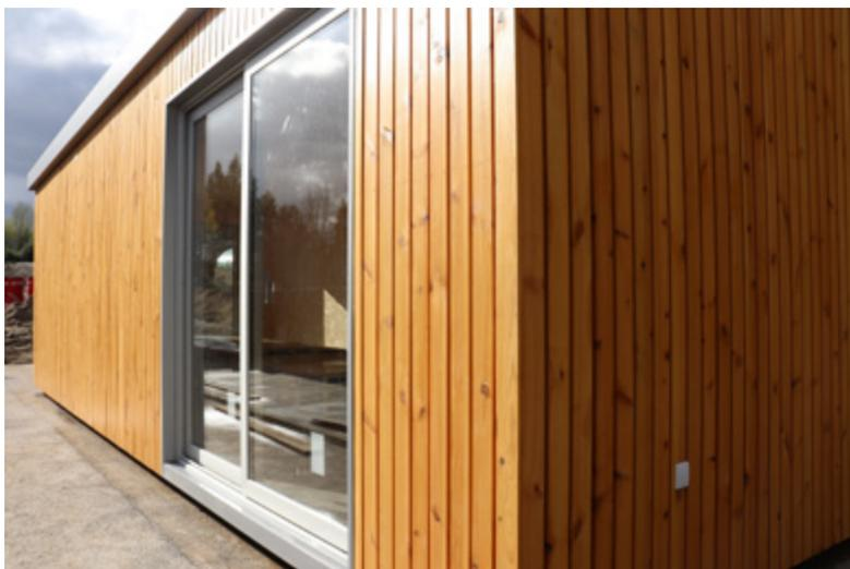
Figura 10: Edifício revestido a placas Coretech®.
